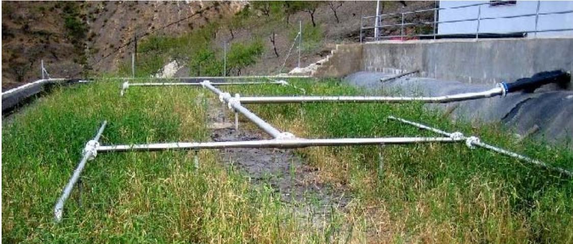
Figura 2: Pré-tratamento de esgotos brutos nos filtros de brita, uma forma especial de wetlands de fluxo vertical
