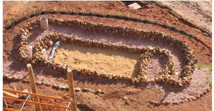
Imagem 7: Planta baixa dos dois sistemas (retangular água cinza, ovalado água negra)
