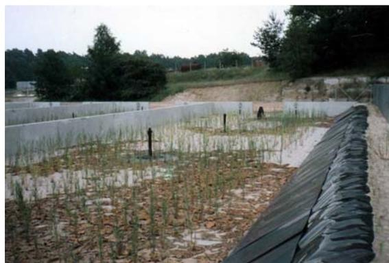
Imagem 6: Canteiro de transformação de lodo em terra (descarte do lodo de excesso)
