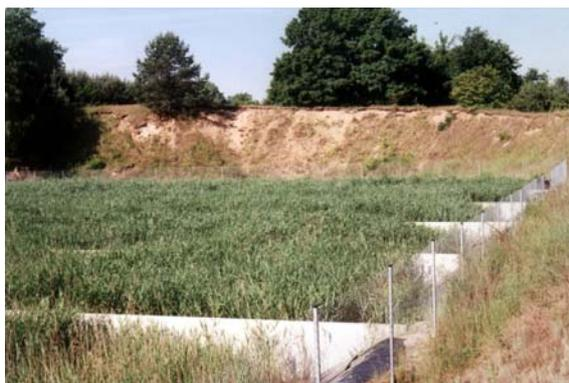
Imagem 5: Canteiro de transformação de lodo em terra (depois de 2 anos em operação)
